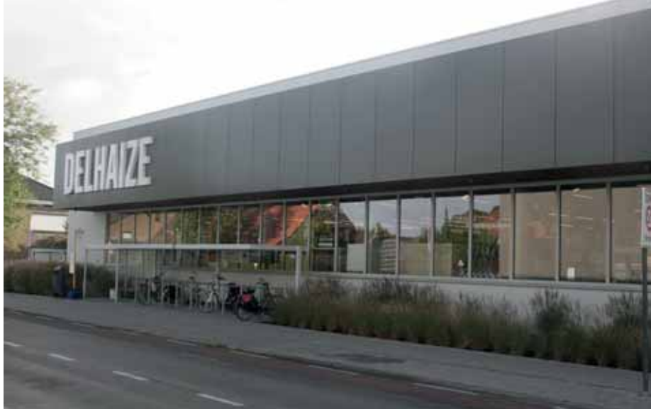
Enkel de zijgevel van de nieuwe supermarkt aan de Brugse Schaakstraat werd volledig opengewerkt, mede omwille van de sociale interactie: vlakbij de inkom, er is een bushalte, er zijn fietsenstallingen. (© PDC)
